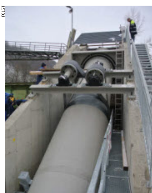
Die neu entwickelte Drehrohr-Doppel-Wasserkraftschnecke: Kein Verletzungsrisiko für Fische und ein effizientes und umwelt-schonendes System
